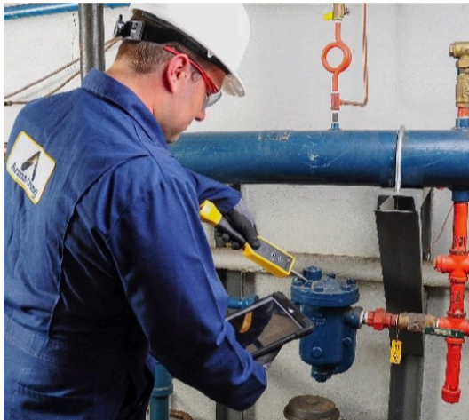
Un technicien qualifié Armstrong qui réalise le test d'un purgeur de vapeur.
