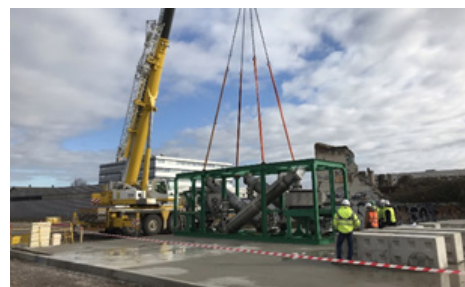
Vue de la mise en oeuvre du SKID - ©R-GDS
